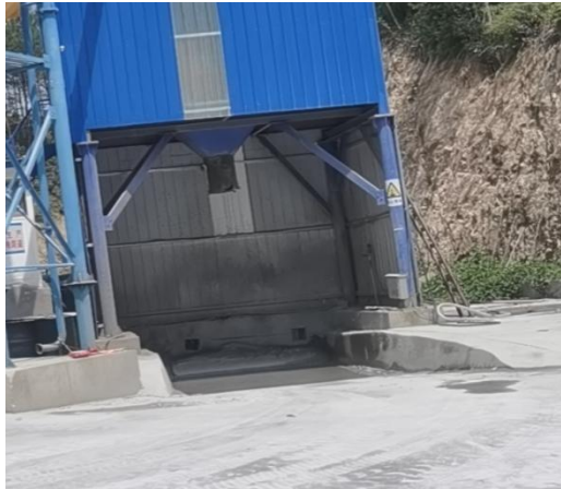
洗车槽（搅拌楼下方）
