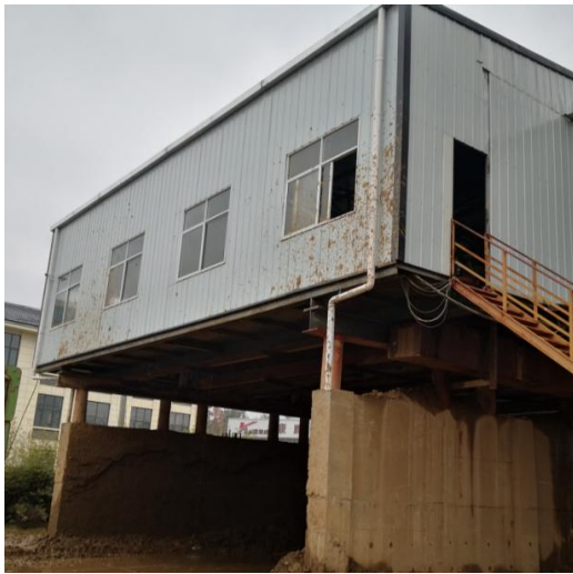
污泥堆存场所
