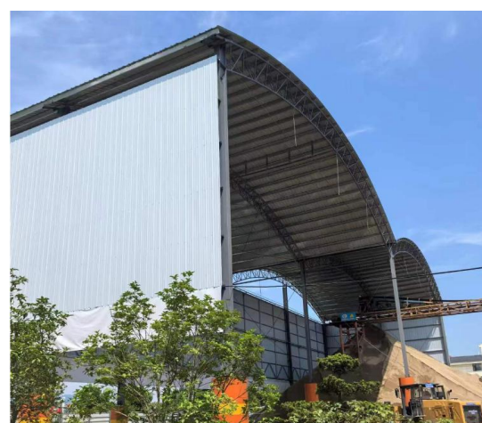
成品堆场半封闭
