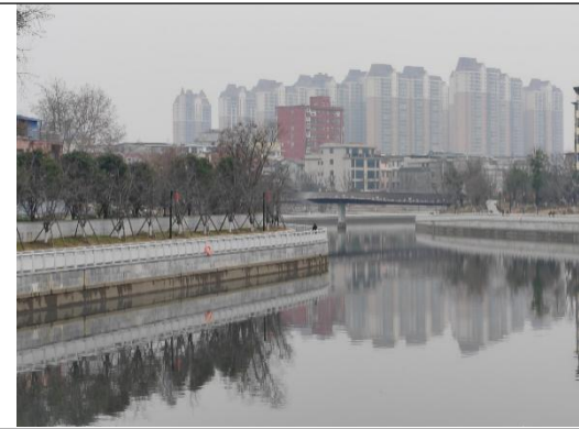
雷溪河桥梁工程
