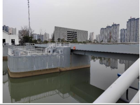
雷溪河翻板闸工程
