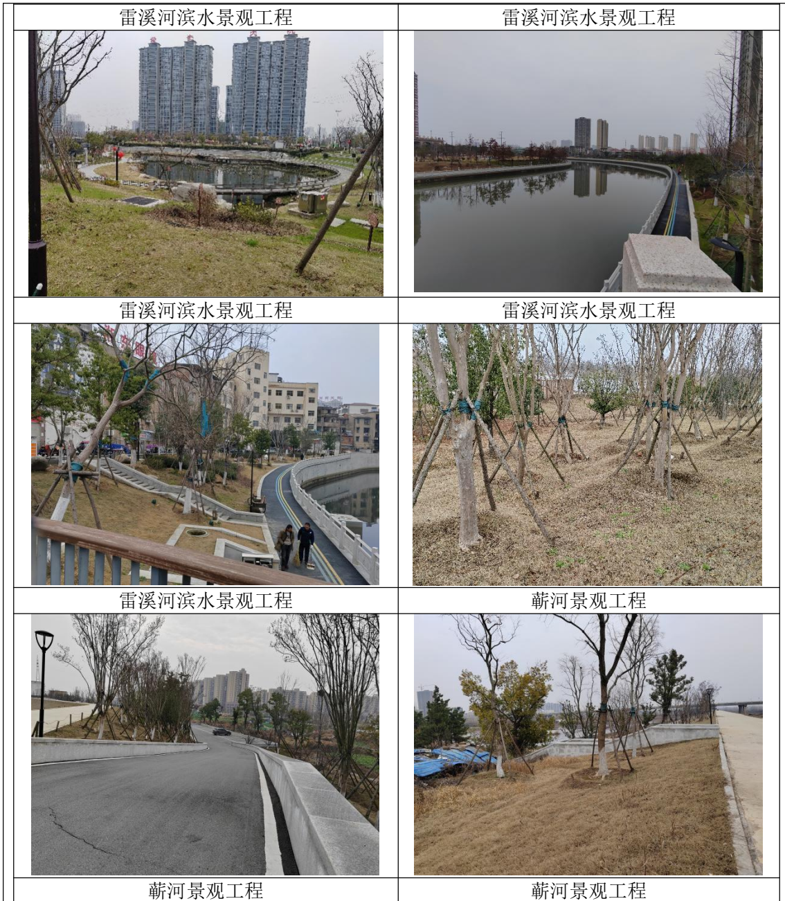
图 4-2 项目实施后照片
