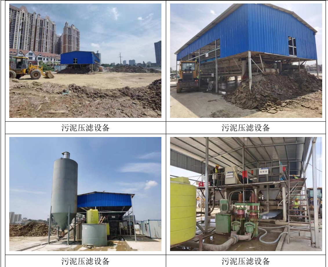
图 4-6 淤泥固化场照片
