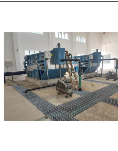
污泥脱水车间
