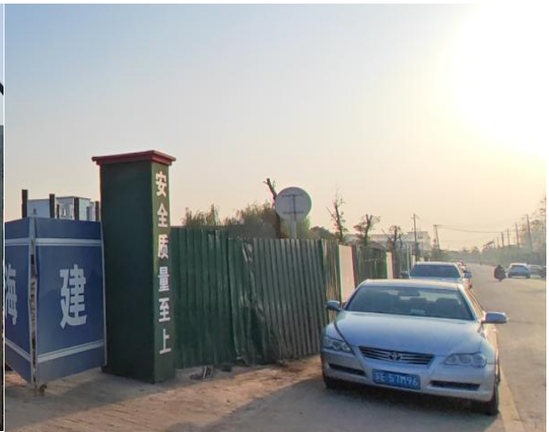
项目北侧现状（紧邻城南路）
