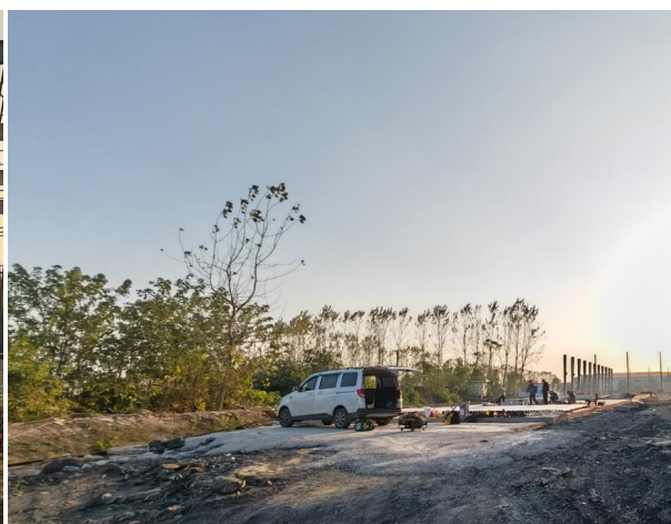
项目建设情况（综合楼区域未建现状）
