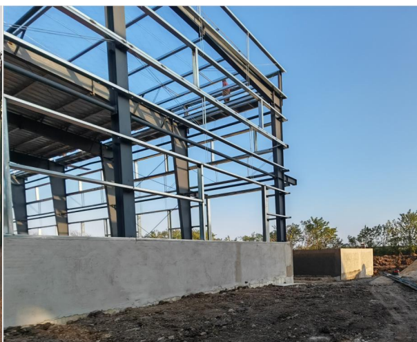
项目建设情况（在建车间）
