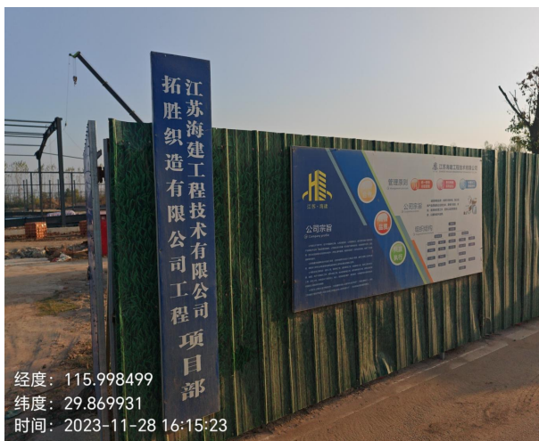
项目建设情况（施工主出入口）
