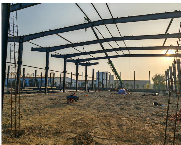
项目建设情况（在建车间内部及施工场地）
