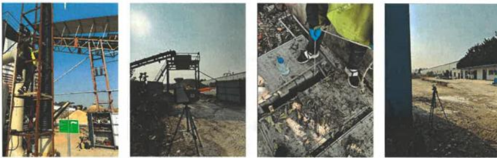
酸性废气排气筒出口
