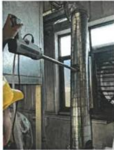
喷漆废气处理设施进口
