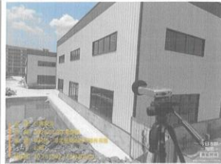
项目东北侧外 1m 处 N4
