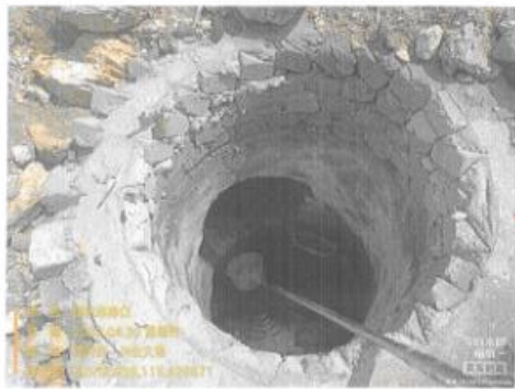
项目废水总排口 DW001
