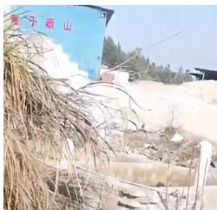
洗车槽沉淀池
